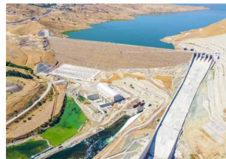
Alpaslan 2 je nová přehrada s vodní elektrárnou na řece Murat o rozloze 55 km 2 . První ze čtyř Francisových turbin byla na konci října spuštěna, celkový instalovaný výkon bude 280 MW
