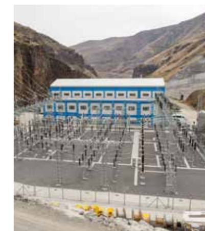
Nová přehrada s vodní elektrárnou Karakurt v povodí řeky Aras zabírá plochu 14 km 2 . První ze tří turbin je už v provozu a vyrábí energii. Celkový instalovaný výkon bude téměř 100 MW
